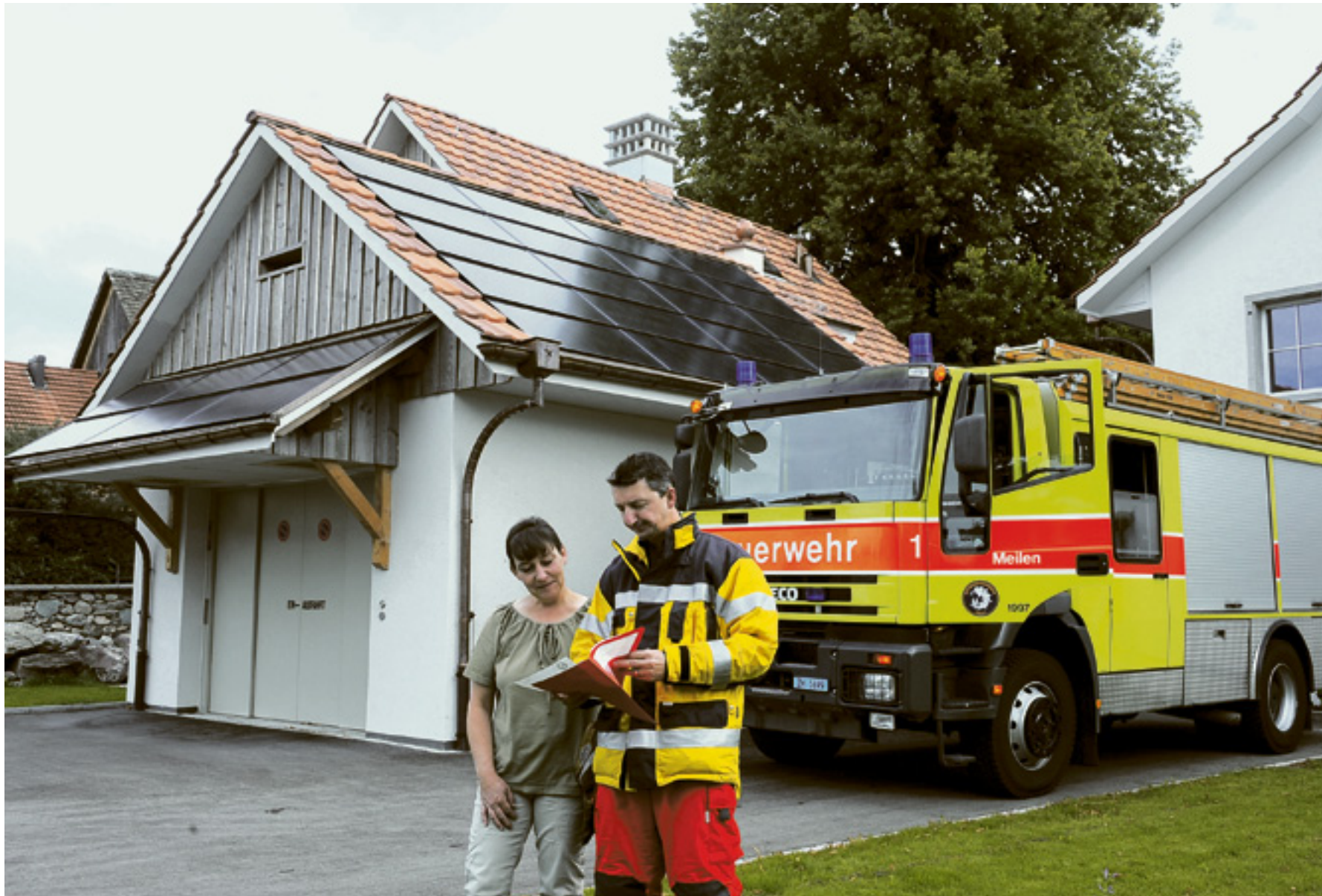
Wenn schon Photovoltaik-Anlage auf dem Dach, dann wünscht sich die Feuerwehr eine offene Zusammenarbeit mit den Hauseigentümern, wie sie hier Stabsoffizier Peter Bösch von der Stützpunktfeuerwehr Meilen bei Eveline Frei in Herrliberg-Wetzwil erhält. Bilder: Reto Schneider
