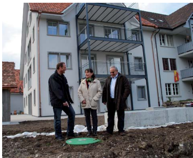
Familie Weber-Frei mit Architekt vor dem erdverlegten Flüssiggastank, der Gas für das energieautarke Mehrfamilienhaus liefert.
