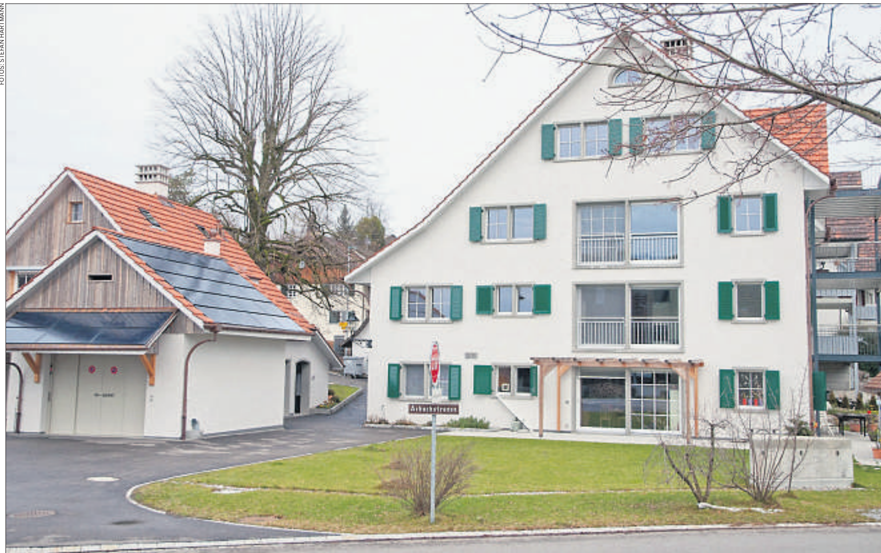
Sonnenfänger auf dem Dach, ein kleines Heizkraftwerk im Keller: Energetisch autarkes Mehrfamilienhaus in Wetzwil ob Herrliberg (ZH).
